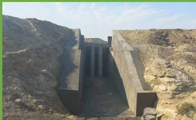
پایان پروژه عملیات مرمت و بازسازی سازه آبخیزداری حوزه رمچاه ، شهرستان قشم
